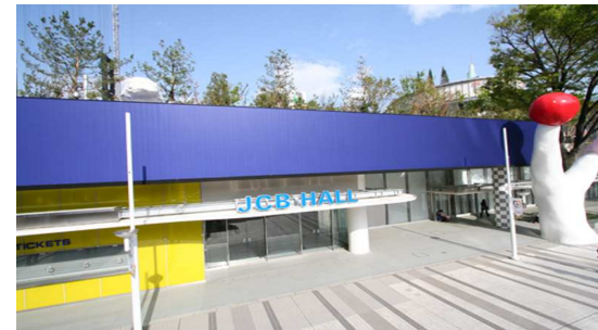
ミーツポート内 JCBホール外観
