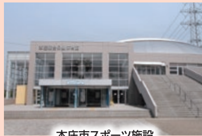
本庄市スポーツ施設
