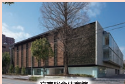
文京総合体育館 ほか6施設
