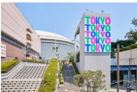
＜プリズムホール塔体ビジョン＞
